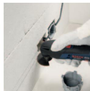
Glodanje žlebova u poroznom betonu, za postavljanje kablova i cevi ispod maltera.
