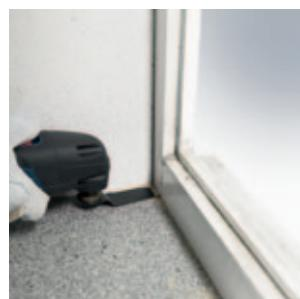
Zasecanje uranjanjem u drvo i metal, npr. za ugradnju prozorskih okvira ili ugradnju okvira vrata.
