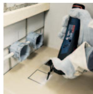
Zasecanje uranjanjem u pločama od gipskartona bez poteškoća.
