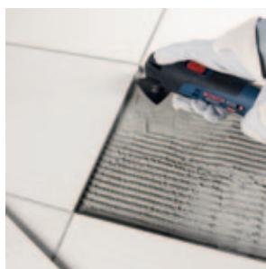
Uklanjanje tvrdokornog maltera ili lepka za pločice, npr. kod izmene oštećenih pločica.
